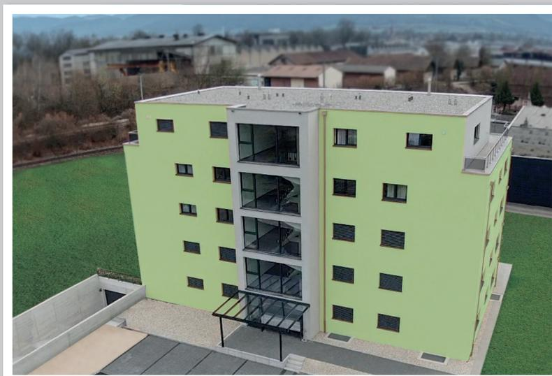
Le toit de l'immeuble est en béton armé. Il répond aux caractéristiques suivantes: barrière vapeur en bitume, isolation thermique en panneau polyuréthane PU 20 cm, étanchéité type multicouche ou matière synthétique avec couche de protection, gravier, tôle en zinc-titane pour les acrotères.
